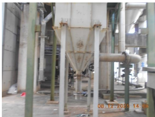
รูปที่ 3 Bag Filter ในระบบบำบัดแก๊สในถ่าน
